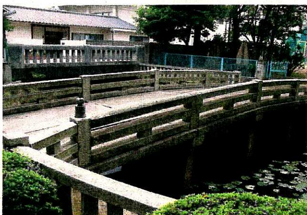
泮池に架かる石桁橋(南東から)
