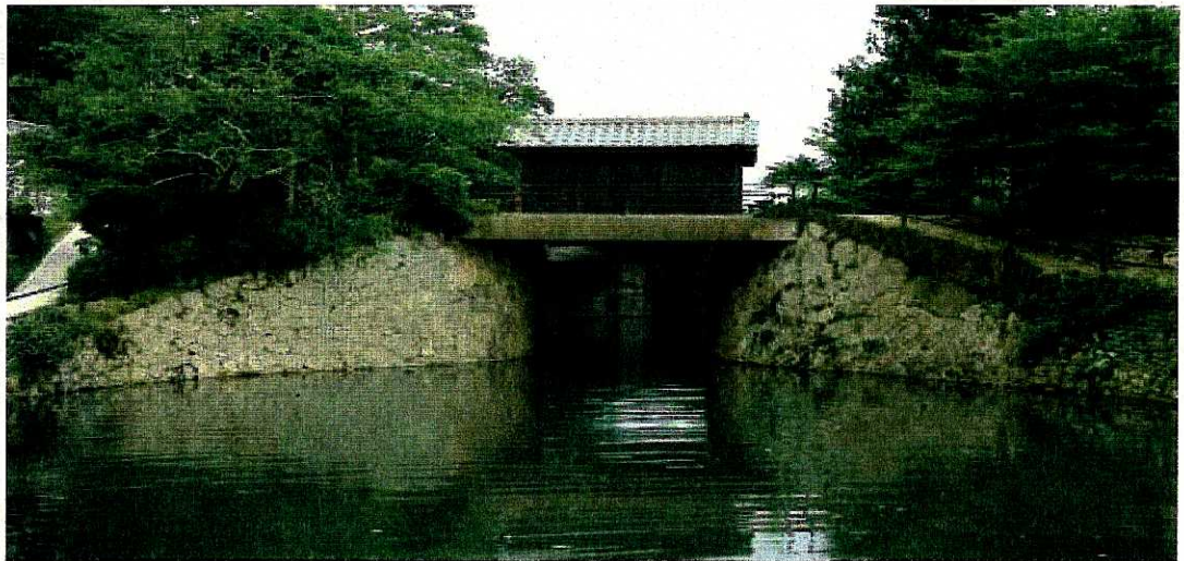
西の倉安川側から
