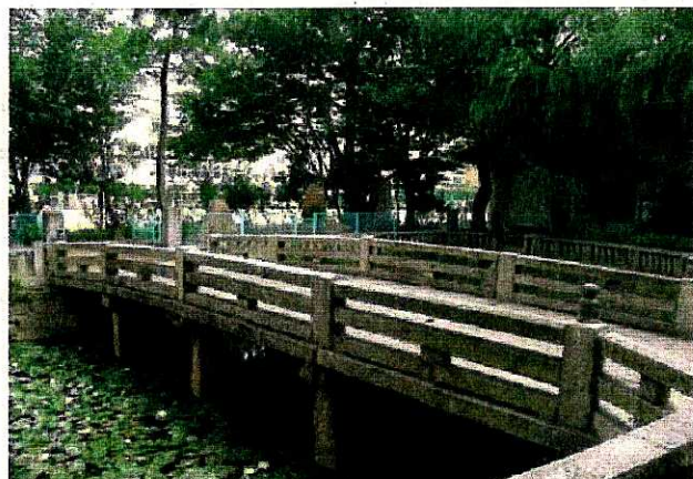
泮池に架かる石桁橋(南西から)
