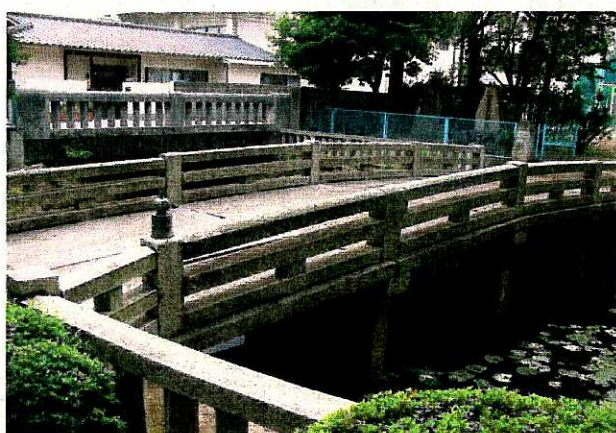
泮池に架かる石桁橋(南東から)
