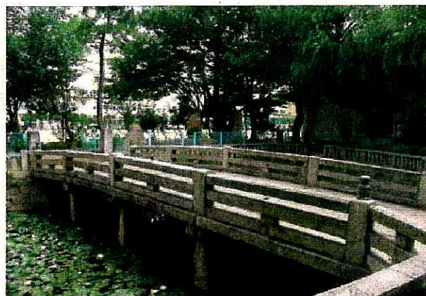
泮池に架かる石桁橋(南西から)
