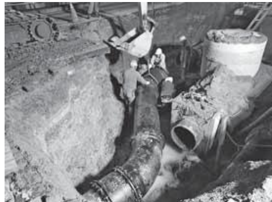
水道管工事の様子
