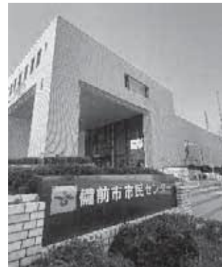
備前市市民センター
