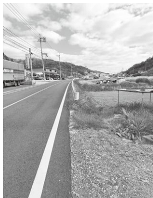
国道250号 木生付近
