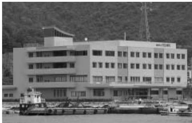
▲平成18年3月に新築移転した市立日生病院
