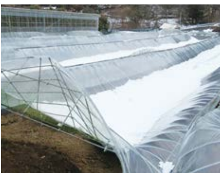
降雪で倒壊したハウス
