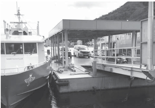
日生港 定期船栈橋
