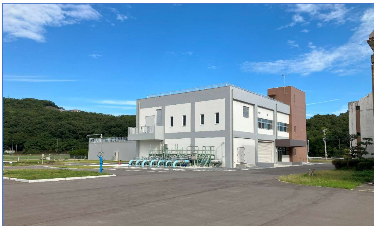
(備前市坂根浄水場)
