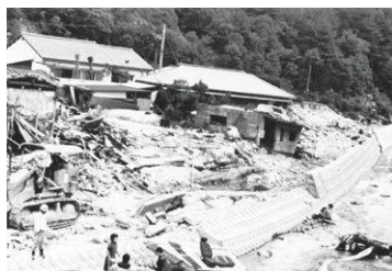
金剛川三石地内【災害時】
