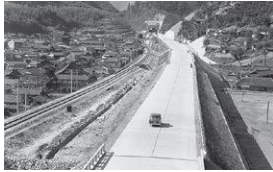
国道2号線(西片上) (出典:岡山県立記録資料館)
