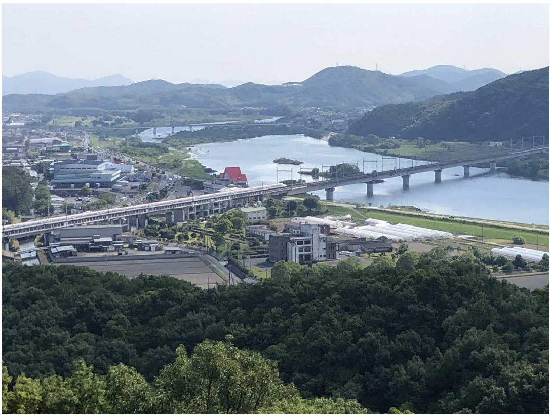
(備前市坂根浄水場)
