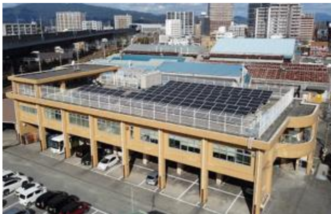
出典) 久留米市環境部庁舎のZEB化事例
