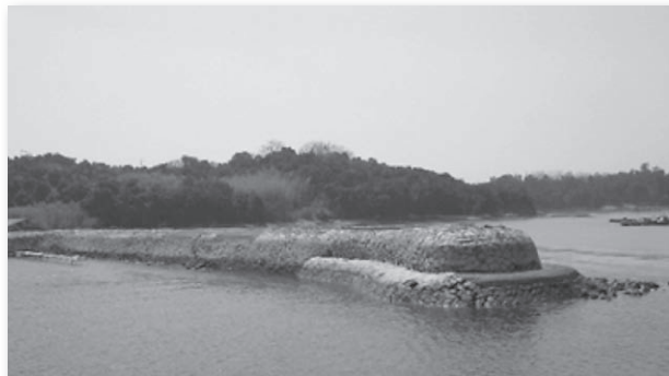
おお た ぶ ぎょこうげんろくぼう は てい 大多府漁港元禄防波堤 (国登録有形)
