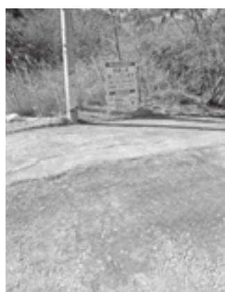
鴻島1号線拡幅工事
