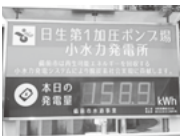
木生地区の小水力発電所
