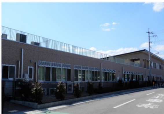
(左) 施設裏側フェンス エアコンの室外機や、植栽があるが、水やりやメンテナンスなどのための出入口が設けられていなかった。
