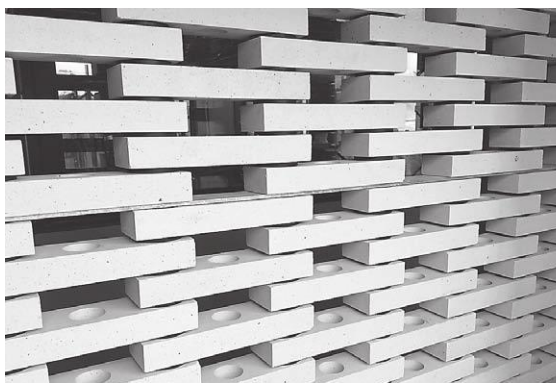
3階～6階 耐火レンガ透かし積み
