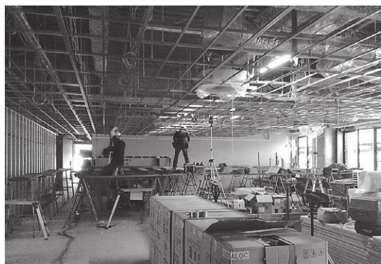
5階執務室 天井下地取付け中
