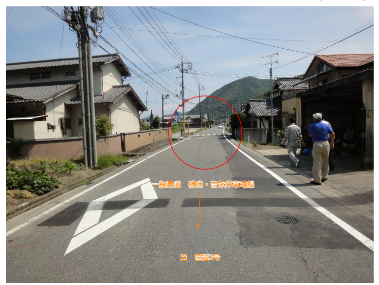
通学路危険箇所 (横断歩道)
