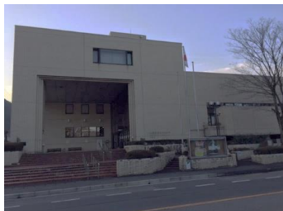
備前市市民センター
