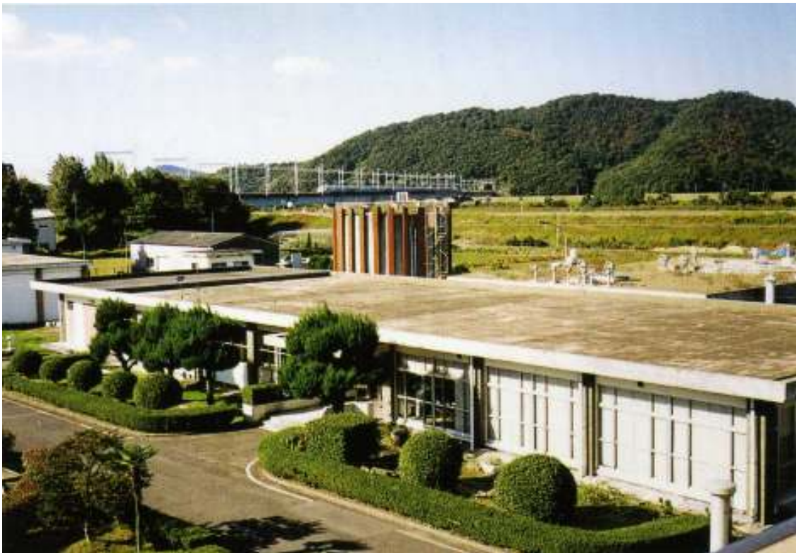
(備前市坂根浄水場)
